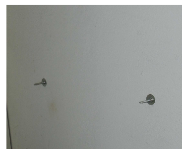
6 FORARE IL MURO CON PUNTA diametro 9 E INSERIRE I TASSELLI IN DOTAZIONE
