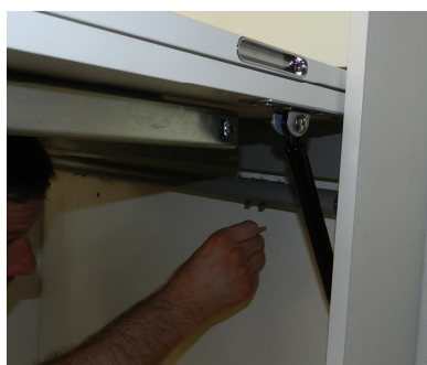
5 ATTRAVERSO I BUCHI POSTI SOTTO IL PIANO ,SEGNARE CON UNA MATITA LA PARETE
